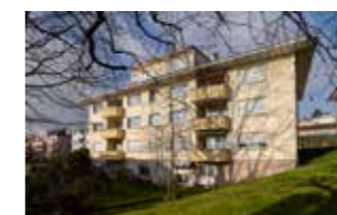
PULLY Chemin de Caudoz 39
