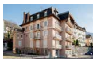
MONTREUX Avenue de Belmont 38 et rue de l'Ancien Stand 4
