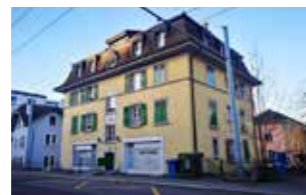
LAUSANNE Avenue de France 69
