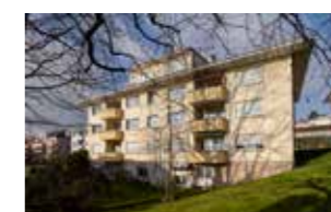
PULLY Chemin de Caudoz 39
