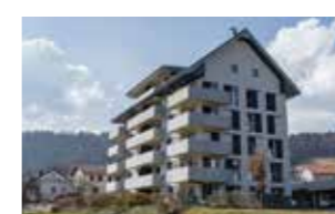
SAINTE-CROIX Rue du Centre 3
