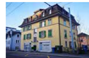
LAUSANNE Avenue de France 69
