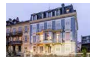
MORGES Rue des Charpentiers 32
