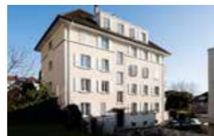
LAUSANNE Chemin du Reposoir 9
