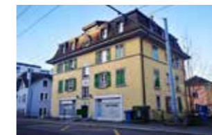
LAUSANNE Avenue de France 69
