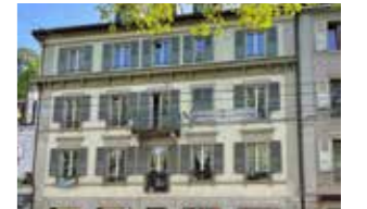
LAUSANNE Place du Tunnel 11
