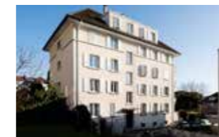
LAUSANNE Chemin du Reposoir 9
