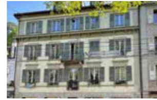
LAUSANNE Place du Tunnel 11
